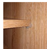
棚受けは、全て耐震ダボ L字のフックが棚板の脱落を 押さえます
